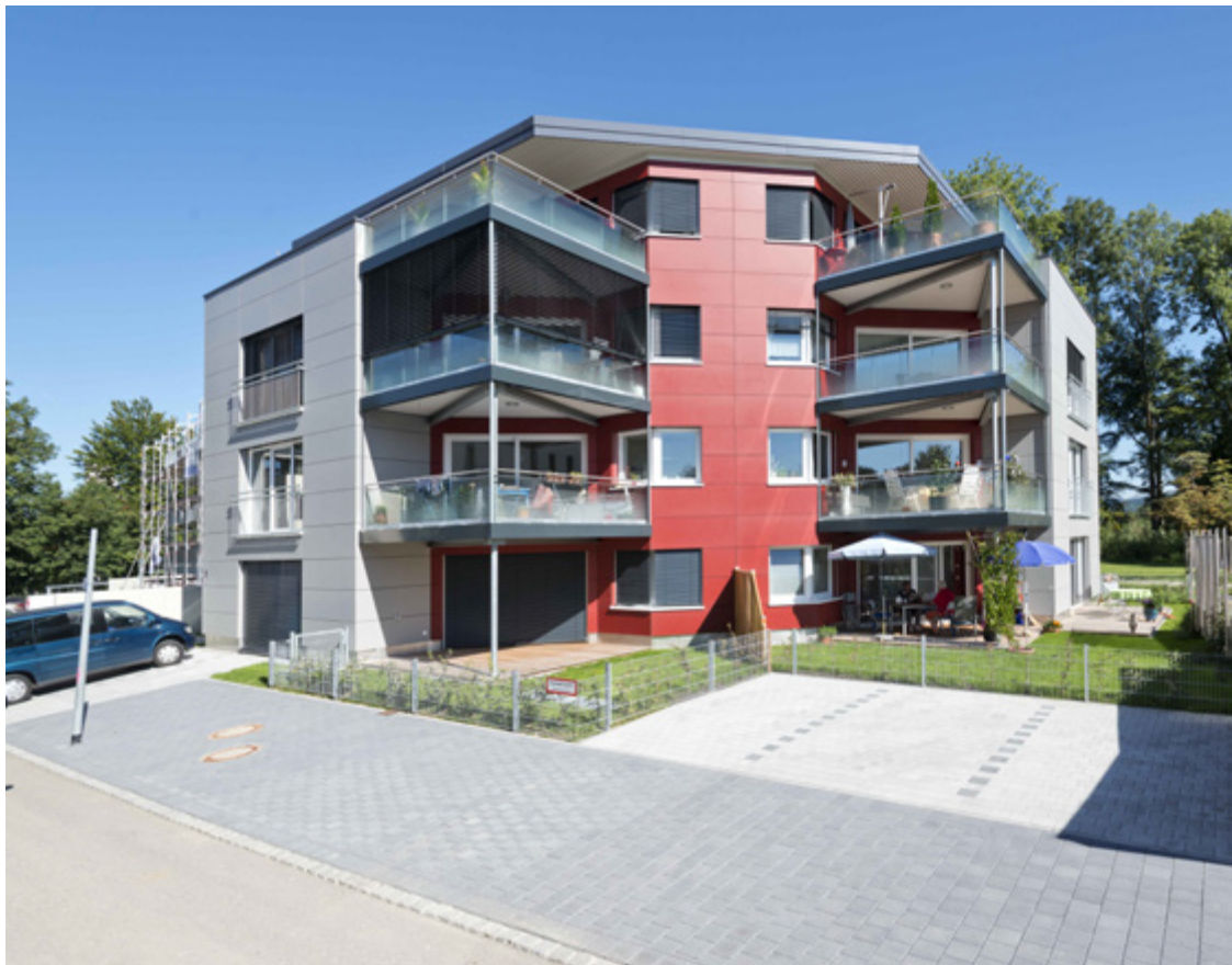
Gebäude aus Holz mehrgeschossig; Foto Jarde Holzbau
