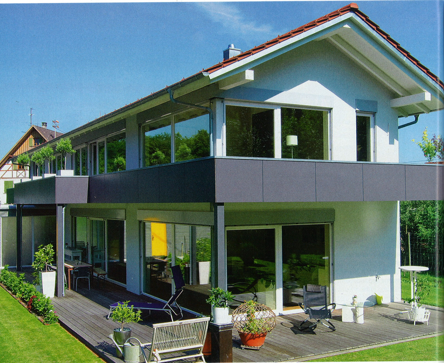
Der umlaufende Balkon bietet nicht nur „Freiluft-Anschluss“ fürs Obergeschoss, sondern schützt auch das Erdgeschoss vor der hoch stehenden Sommersonne.
